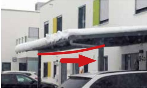
Bei fast allen Terrassenüberdachungen aus Aluminium ist die Regenrinne ein tragendes Element. Die Stützpfeiler unter der Regenrinne müssen dabei zwingend an den dafür vorgesehenen Befestigungspunkten montiert werden. Deswegen sitzen die Pfeiler von Schmidt Überdachungen immer direkt unter der Regenrinne. Keinesfalls dürfen die Pfeiler nach innen versetzt werden. Sonst ist die berechnete Statik der Dachkonstruktion nicht mehr gewährleistet.
